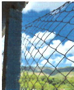
Foto 3: CERCO O MURO PERIMETRAL Sustitución malla de acero galvanizado en perímetro del establecimiento, con instalación fija y tensa, anclajes metálicos en intervalos regulares
