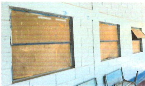
Foto1: VENTANAS Sustitución de ventanas; sistema de apertura: Corredizas, Perfiles color blanco estandar, Material del marco: PVC Material de la ventana: Vidrio, sellado perimetral.
