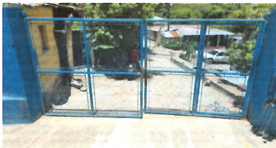
Foto 5: MANTENIMIENTO A PORTONES Mantenimiento a portón de ingreso, material: metálico, incluye: bisagras y sistemas de cierre.
