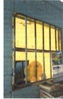
Foto 2: VENTANAS Reparación de balcones metálicos, incluyendo fijaciones, pintura y soldaduras.
